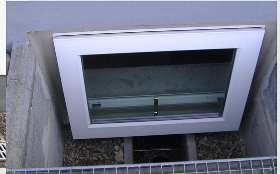
Druckwasserdichte Fenster, Quelle: Wenzler Bausysteme
