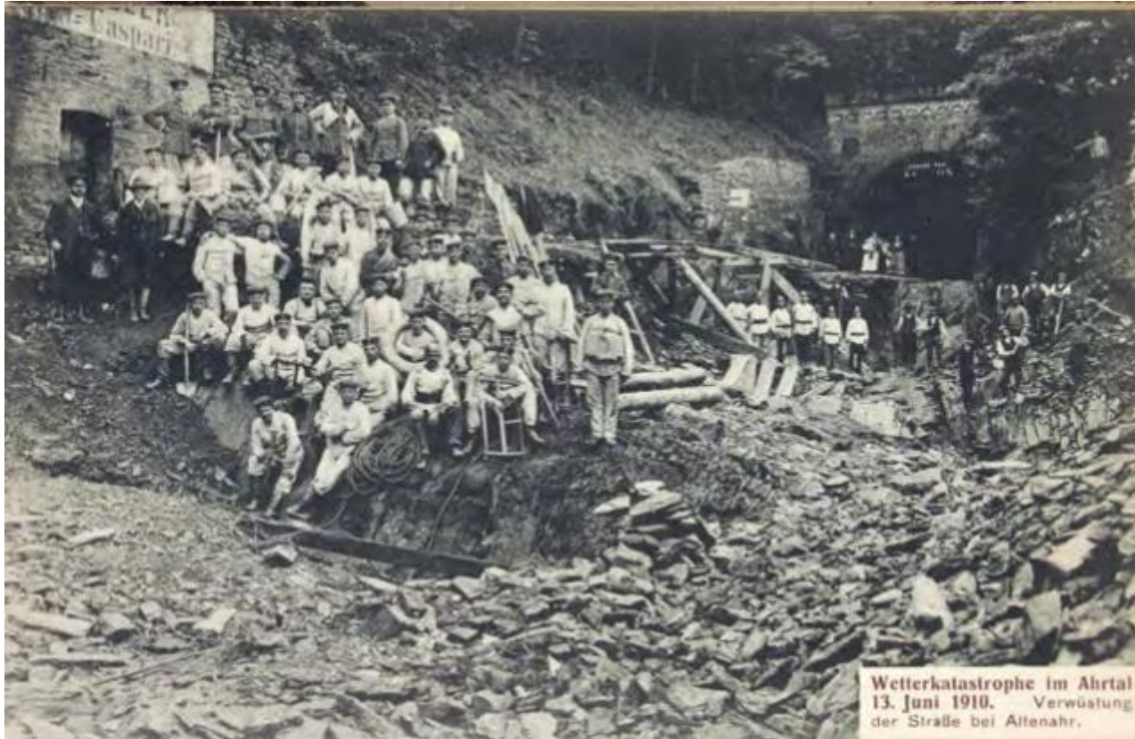
Tunnel Altenahr nach dem Hochwasser von 1910
