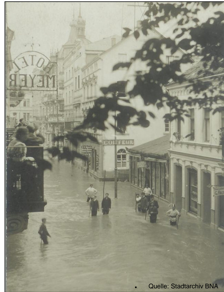
Hochwasser vom 13. Juni 1910 in Bad Neuenahr
